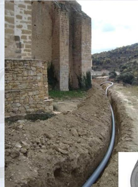
Sistema de tuberías pre-aisladas térmicamente, para agua caliente y fría, que transporta ENERGÍA desde la central hasta los edificios
