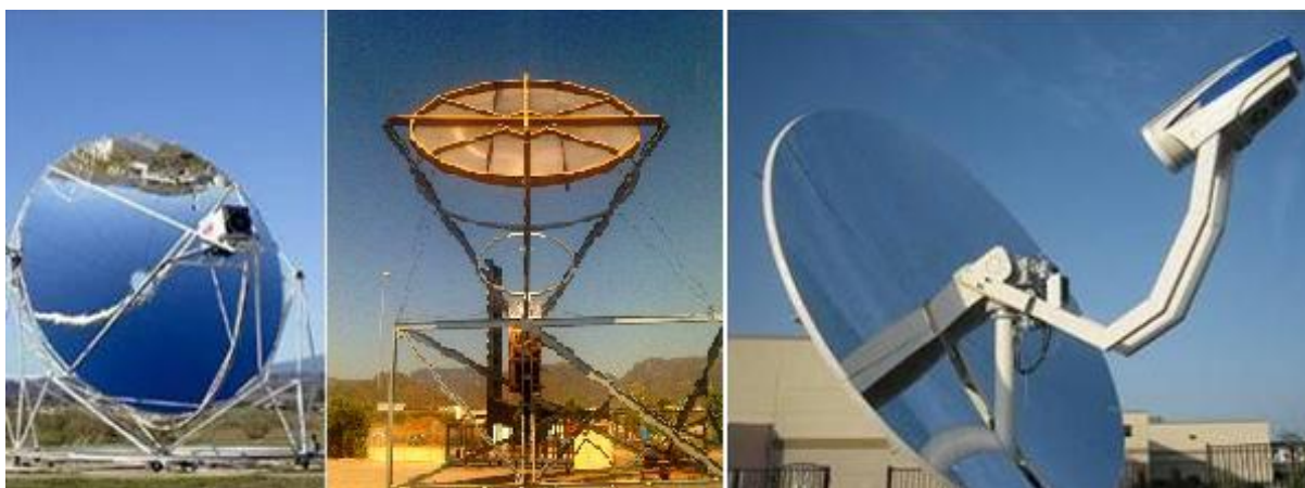
Figura 4.11.8. Instalaciones disco parabólicas en la Plataforma Solar de Almería (izqda.) y prototipos (centro y derecha)
