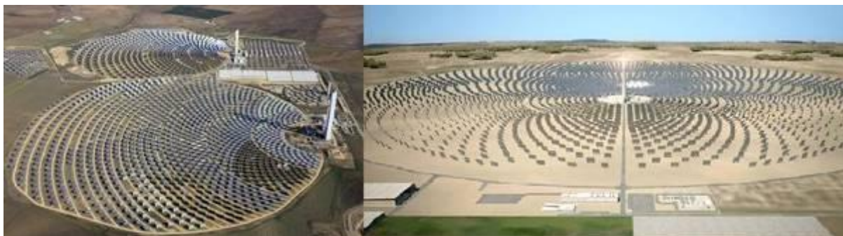
Figura 4.11.7. Centrales de torre PS10 y PS20 del Grupo Abengoa en la Plataforma Solar Sanlúcar la Mayor (izquierda) y la planta Gemasolar propiedad de Torresol Energy (derecha)
